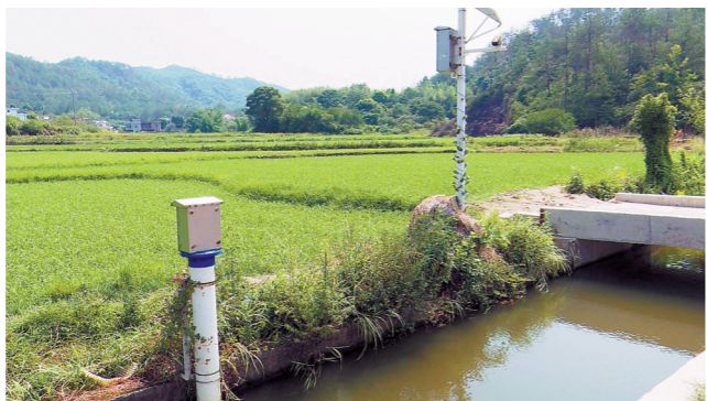
完成改造的灌溉渠道水量充足
