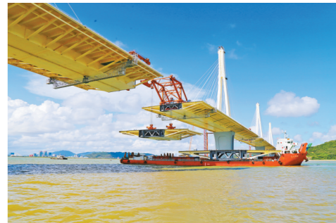
28号墩E6号块架梁
