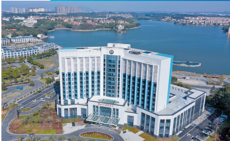
仙湖实验室建设进一步提速,实验室主楼已于2月正式投入使用 (佛山市科技局供图)
