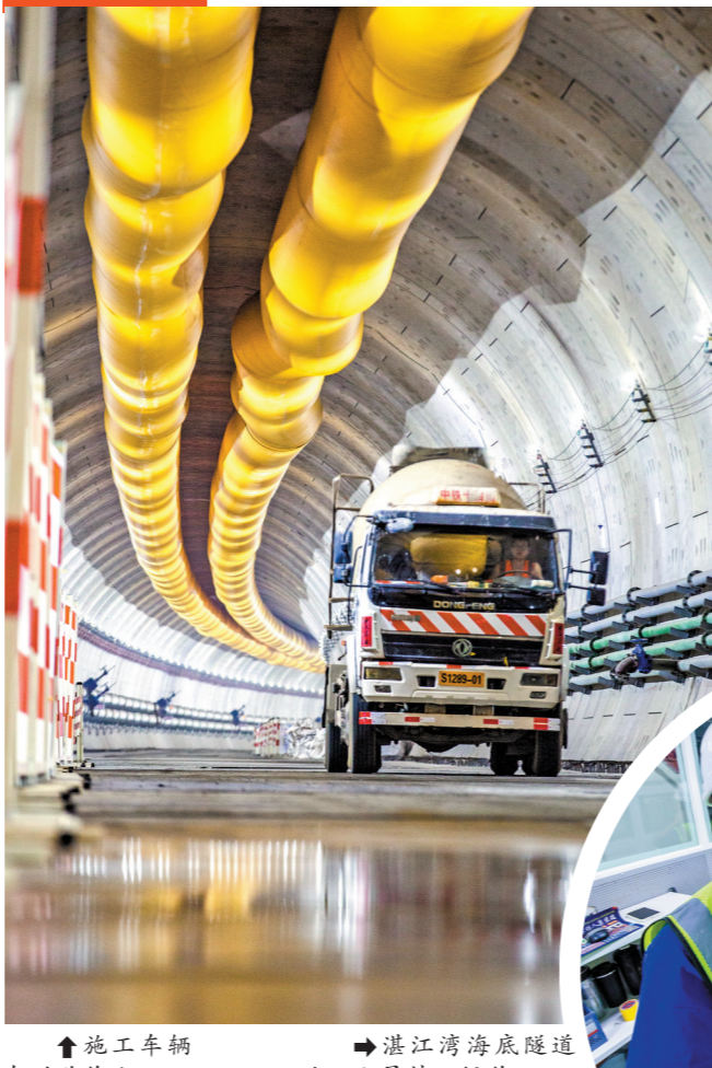
施工车辆在隧道作业
