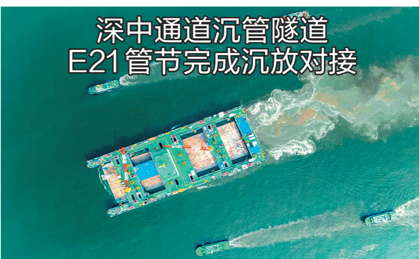
浮运安装一体船正提带深中通道沉管隧道E21管节进行浮运作业 苏振飞 摄
