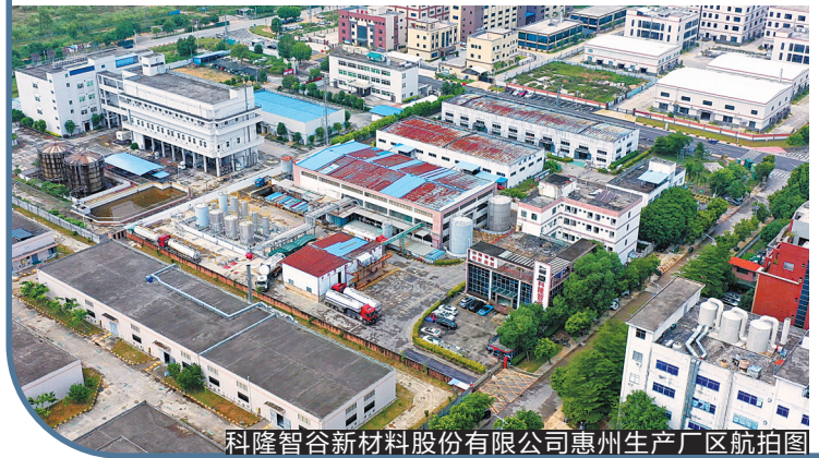
科隆智谷新材料股份有限公司惠州生产厂区航拍图
