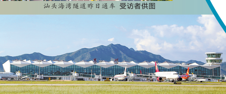
惠州机场飞行区扩建工程昨日开工 通讯员 粤机宣 供图
