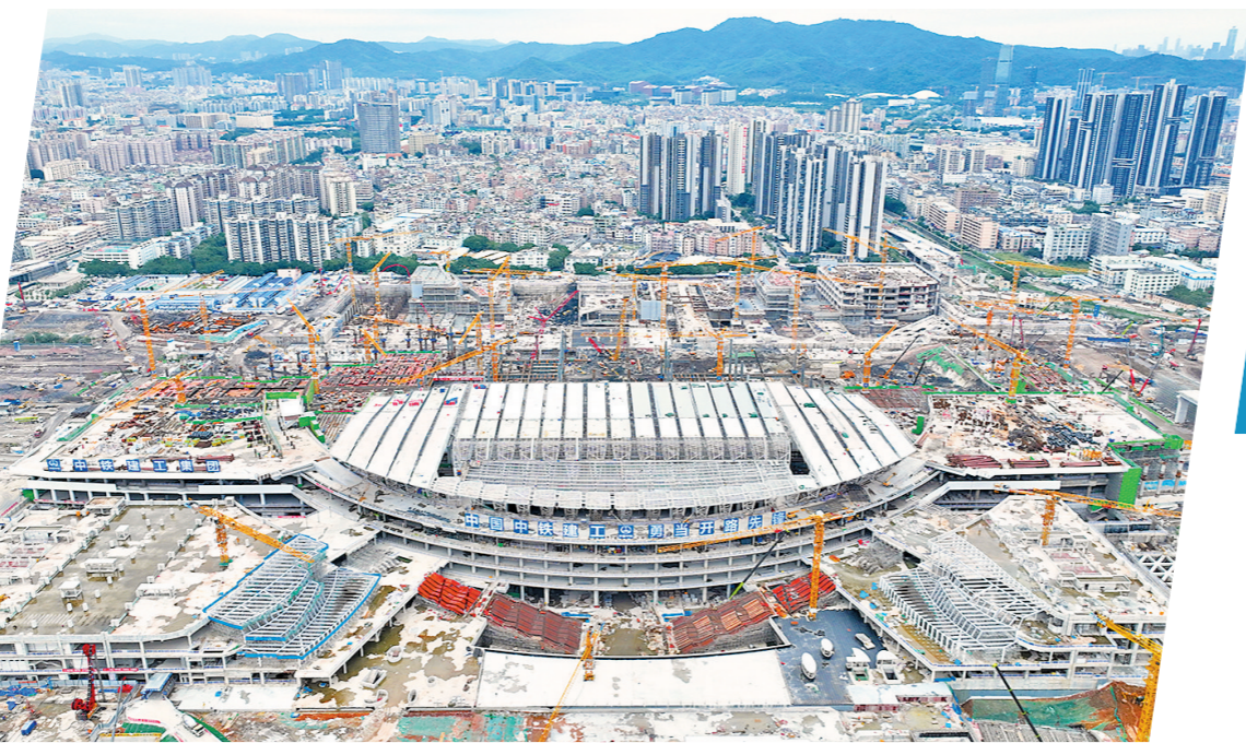
广州白云站项目施工现场航拍
