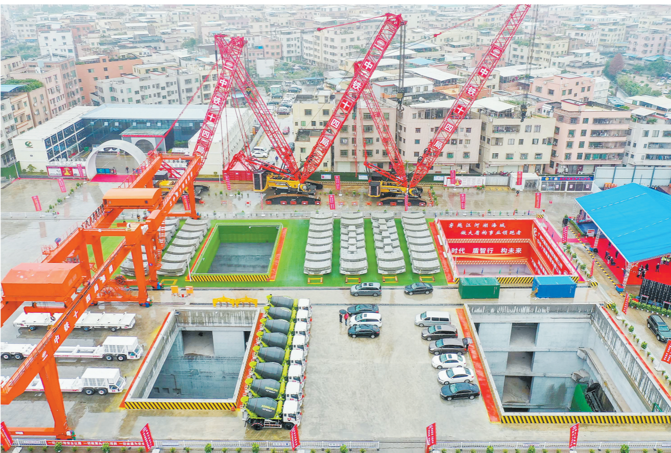
“大道先锋号”盾构机在广州海珠隧道工程西线隧道始发 新华社发
