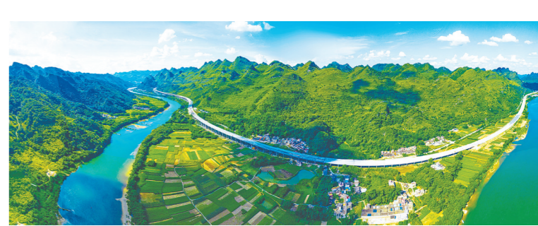
通过绿色施工,广连高速项目大大节约了用电、减少河砂使用 中交四航局供图
