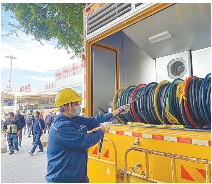
广州火车站,南方电网广州越秀供电局工作人员接入应急电源车
