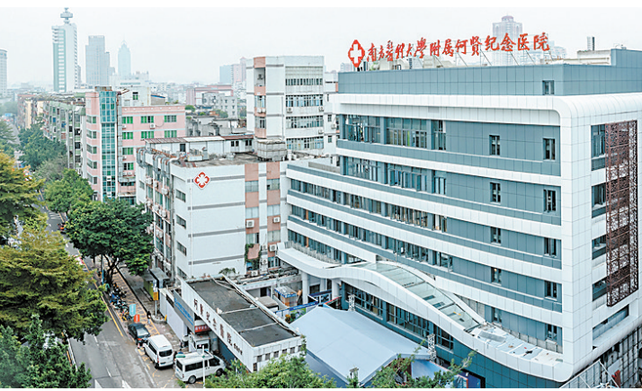
何贤纪念医院旧建筑改造工程医技楼正式落成启用
