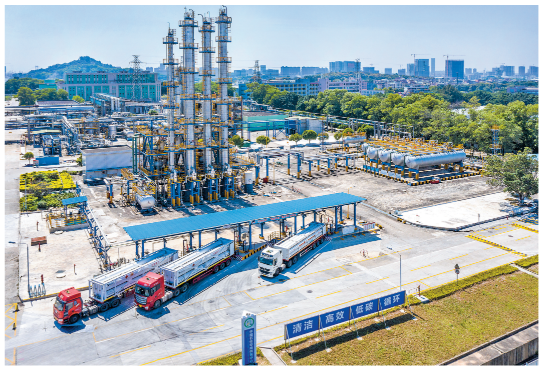
项目投产后将成为华南地区最大的燃料氢供应中心
