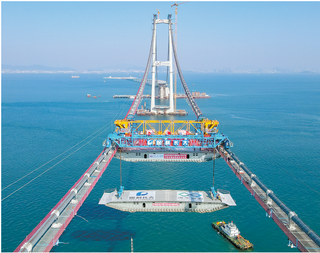
1月29日，伶仃洋大桥主跨西侧首件钢箱梁吊装施工
