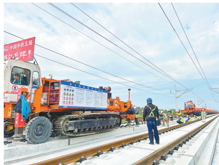
广汕铁路鹤山隧道铺轨现场
