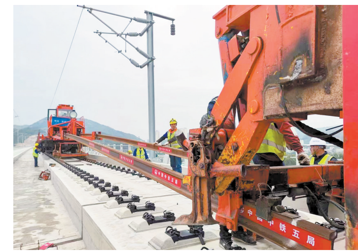
广汕汕铁路施工现场 建设单位供图
