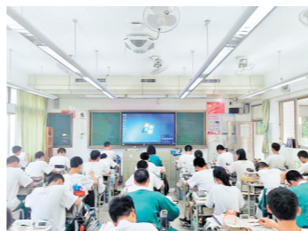
省实已实现吸顶式教学用智能安全音响全覆盖
