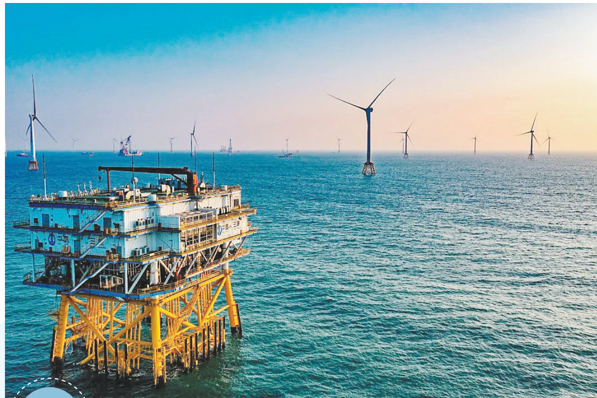
三峡新能源阳江沙扒海上风电场
