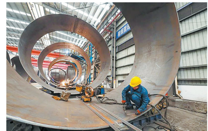
广东粤电新能源装备有限公司的工人正在作业
