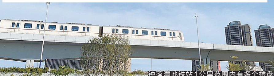
钟落潭地铁站1公里范围内有多个楼盘
