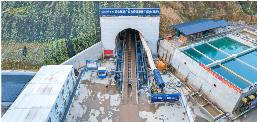
环北部湾广东水资源配置工程(试验段) 省水利厅供图
