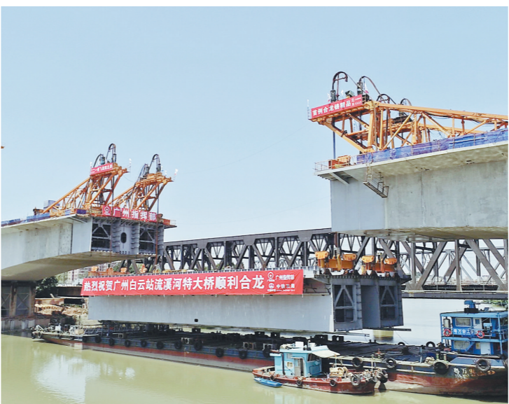
施工现场 通讯员供图
