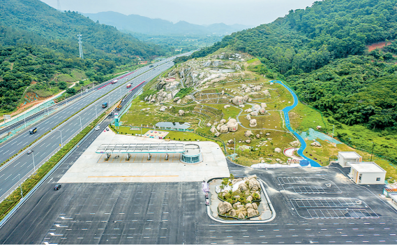
服务区东侧“原石公园”，场区内堆积石块原地保留，成为“山石盆景”，实现了工程建设与生态环保的相融结合
