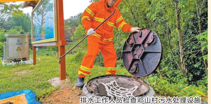
排水工作人员检查邓山村污水处理设施
