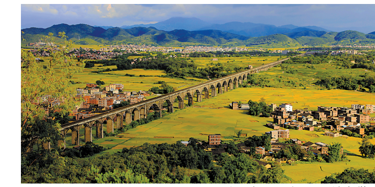
云浮长岗渡槽 受访者供图
