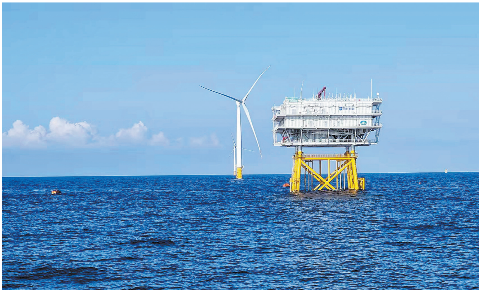
农行助力绿美广东生态建设,为粤港澳大湾区注入金融动能,图为农行广州分行支持的阳江沙扒海上风电项目
