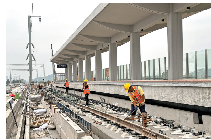
汕汕高铁项目施工现场一片热火朝天
