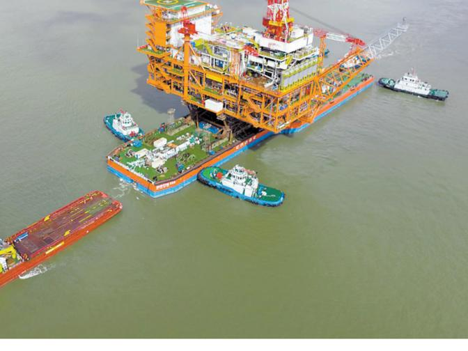
此次启航出海的平台上部组块长77.5米,宽36米,甲板面积近7个篮球场大小,重达14111吨,相当于1万辆家用小汽车的重量。由于采用标准化及数字化建设,其建造周期仅8.5个月,较同类平台建造周期缩短近5个月。技术人员将组块结构细分为15个部分,充分拓展甲板区的预制作业面,吊装最大重量超过560吨,从而缩短吊装作业时间,结构总装仅用时82天。
