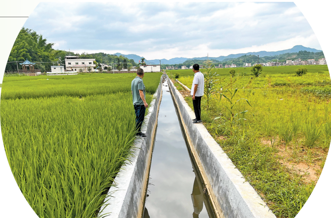
灯塔盆地灌区和平片区月坑中型灌区现代化改造工程改善了和平县东水镇新坪村农田灌溉条件
