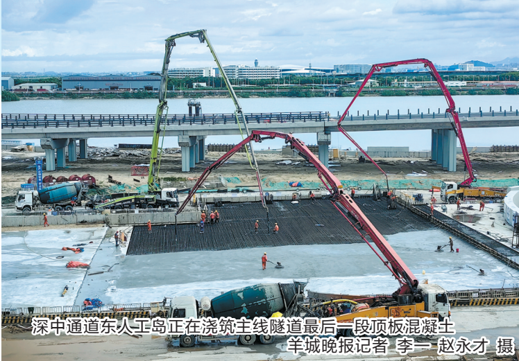
深中通道东人工岛正在浇筑主链隧道最后一段顶板混凝土 羊城晚报记者 李一 赵永才 摄
