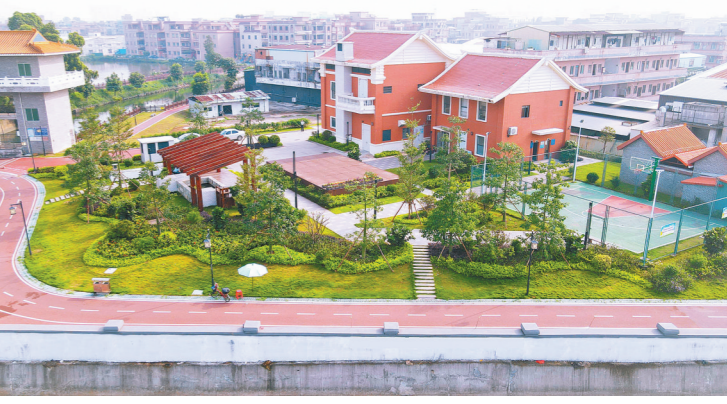
东莞市道滘镇小河村分散式污水处理站
