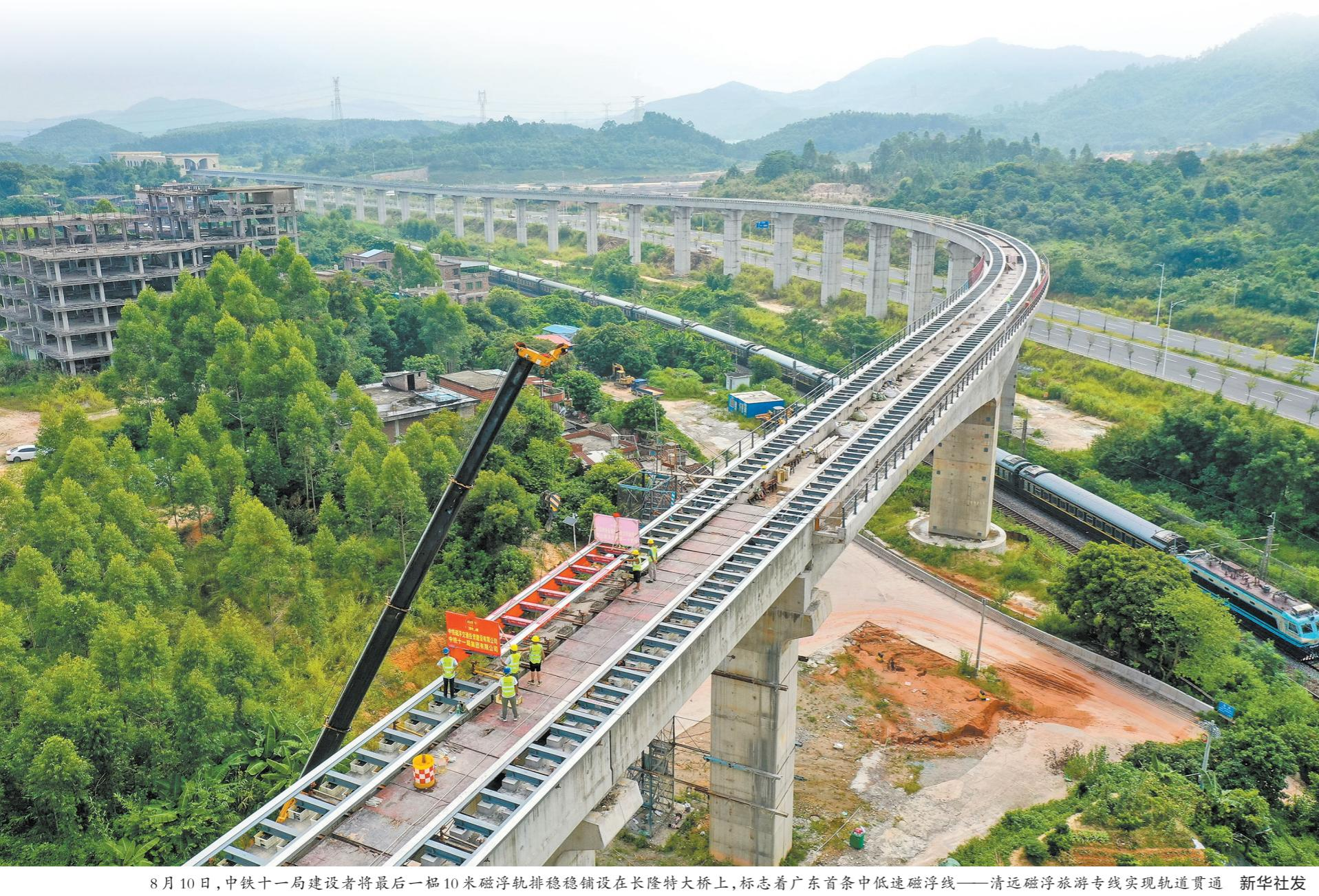
8月10日，中铁十一局建设者将最后一根10米磁浮轨排稳稳铺设在长隆特大桥上，标志着广东首条中低速磁浮线——清远磁浮旅游专线实现轨道贯通 新华社发
