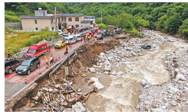
8月12日拍摄的西安市长安区滦镇街道喂子坪村鸡窝子组山洪泥石流灾害现场（无人机照片） 新华社发
