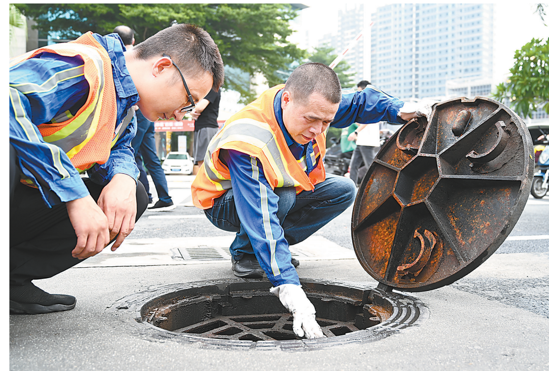
工人开盖检查窨井防坠落装置
