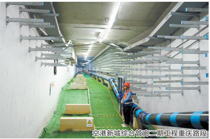
空港新城综合管廊二期工程重庆路段
