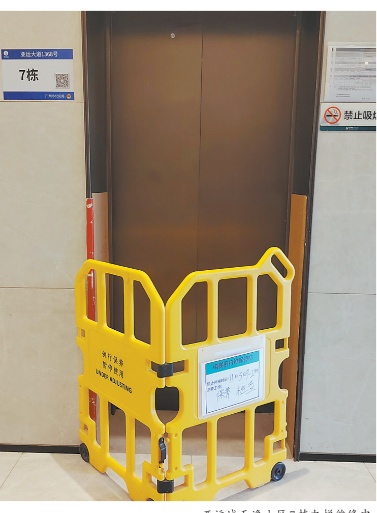
亚运城天逸小区7栋电梯维修中
