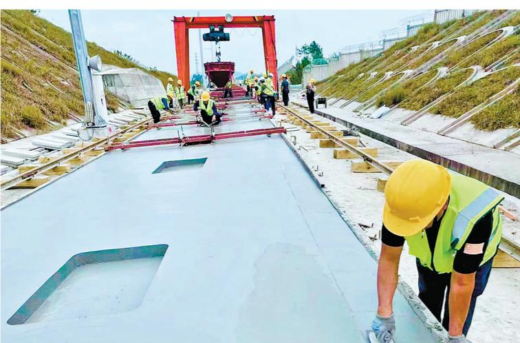
11月8日，随着最后一车混凝土浇筑完成，中铁一局梅龙高铁无砟轨道区间路基DYK95+953.85—DYK96+250.06首件试验段底座板顺利浇筑完成，标志着梅龙5标建设已开始进入无砟轨道施工阶段，为2024年建成通车奠定了坚实的基础。
