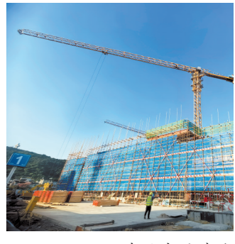
建设中的珠海太空中心(新馆)
