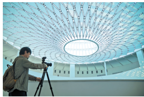
新馆玻璃穹顶
