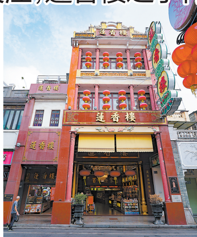
莲香楼（第十甫路）外观
