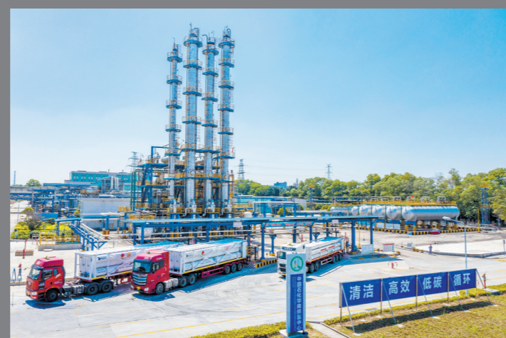
广州石化供氢中心
