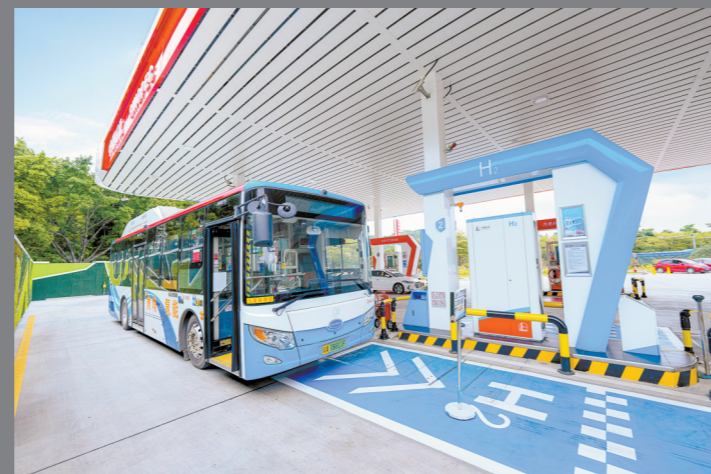
广东石油东明三路综合加能站正在为公交车加氢
