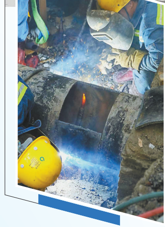
工作人员在寒风中抢抓抢修进度
