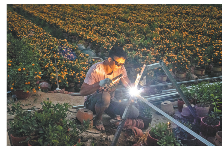
陈大哥在年桔地里自己动手焊接棚架
