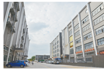
神湾镇外沙村“工改”腾挪园内崭新的厂房 张德钢摄
