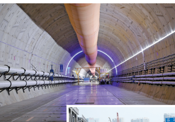
珠江口隧道南沙端施工现场
