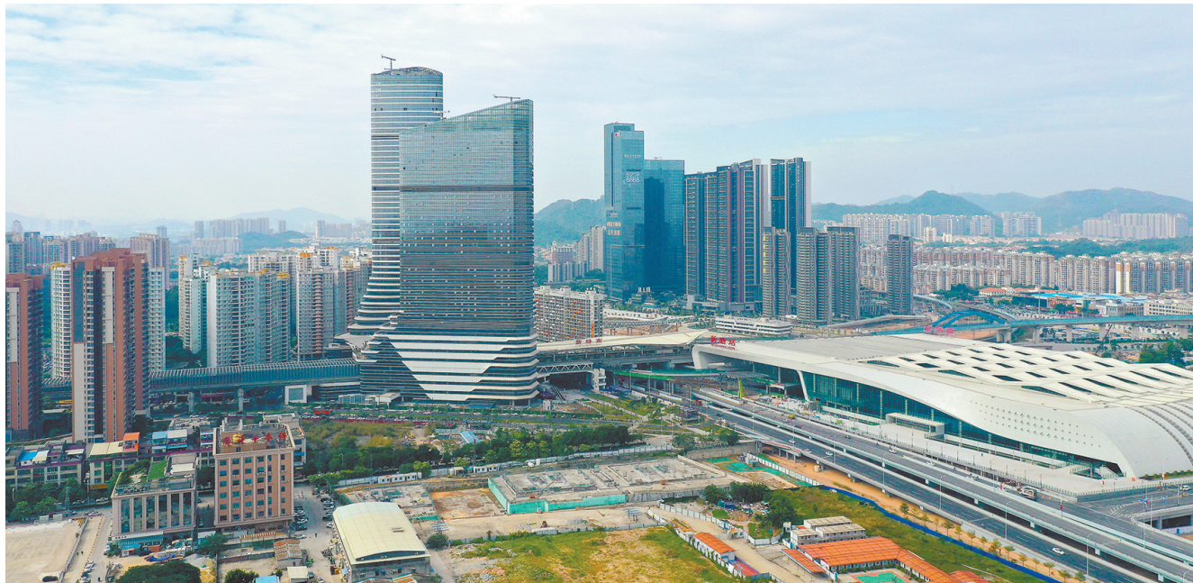
位于广州增城的东部地铁枢纽——新塘站
