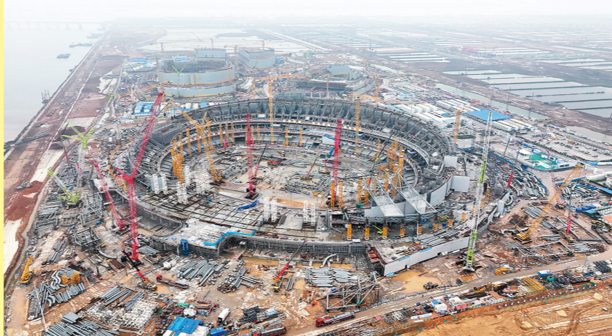
主体结构封顶提前20天完成
