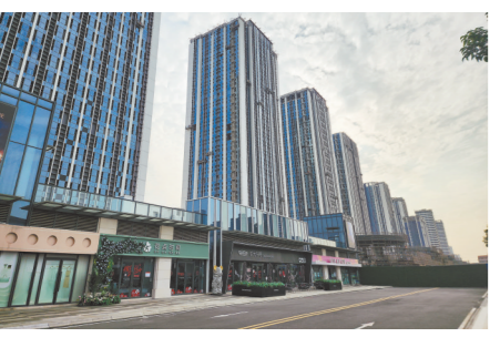
组团一地块目前正在进行外立面施工
