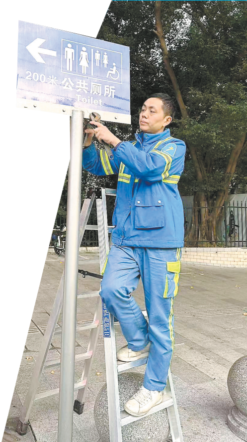
粟敏铭正在维修公厕设施
