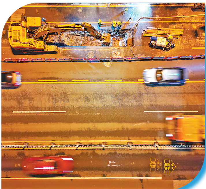
广州市自来水有限公司对老旧市政管网进行改造
