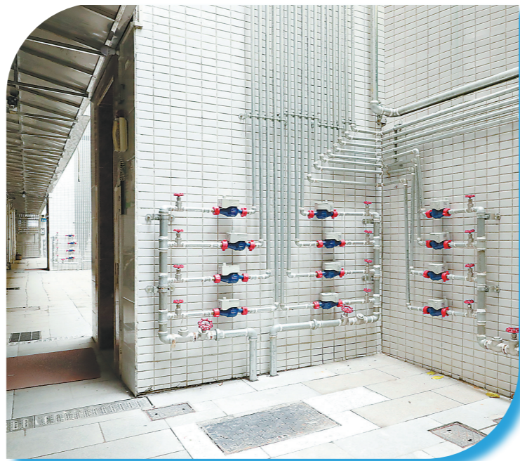
“供水服务到终端”改造后，老旧小区用上新的供水设施
