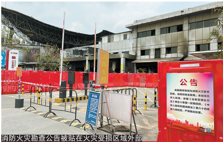
消防火灾勘查公告被贴在火灾受损区域外部
