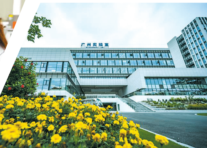
位于广州国际生物岛的广州国家实验室 实验室供图
