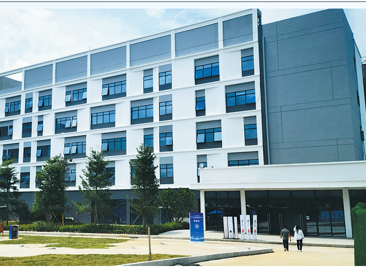
中国电信粤港澳大湾区一体化数据中心项目
